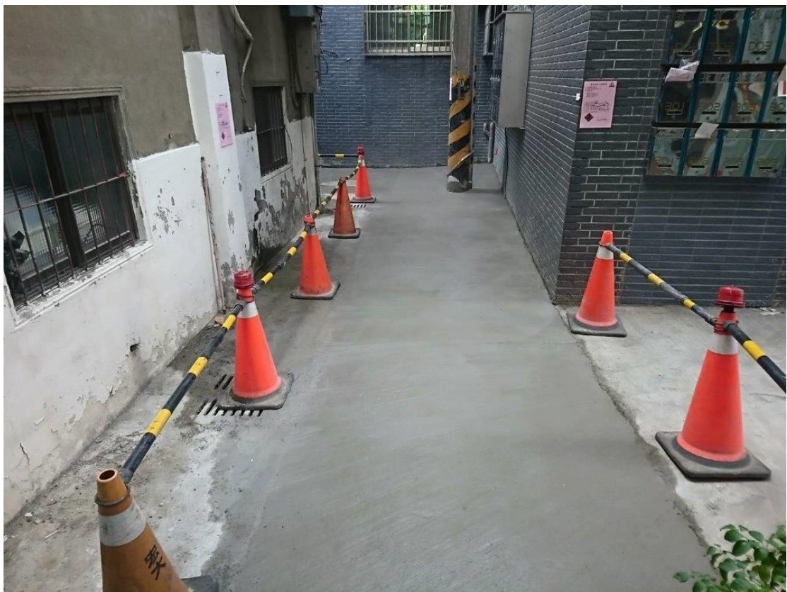
工區七 東區旱溪里東光路 76 巷 3 弄路面改善工程（上圖三張完工照片）
