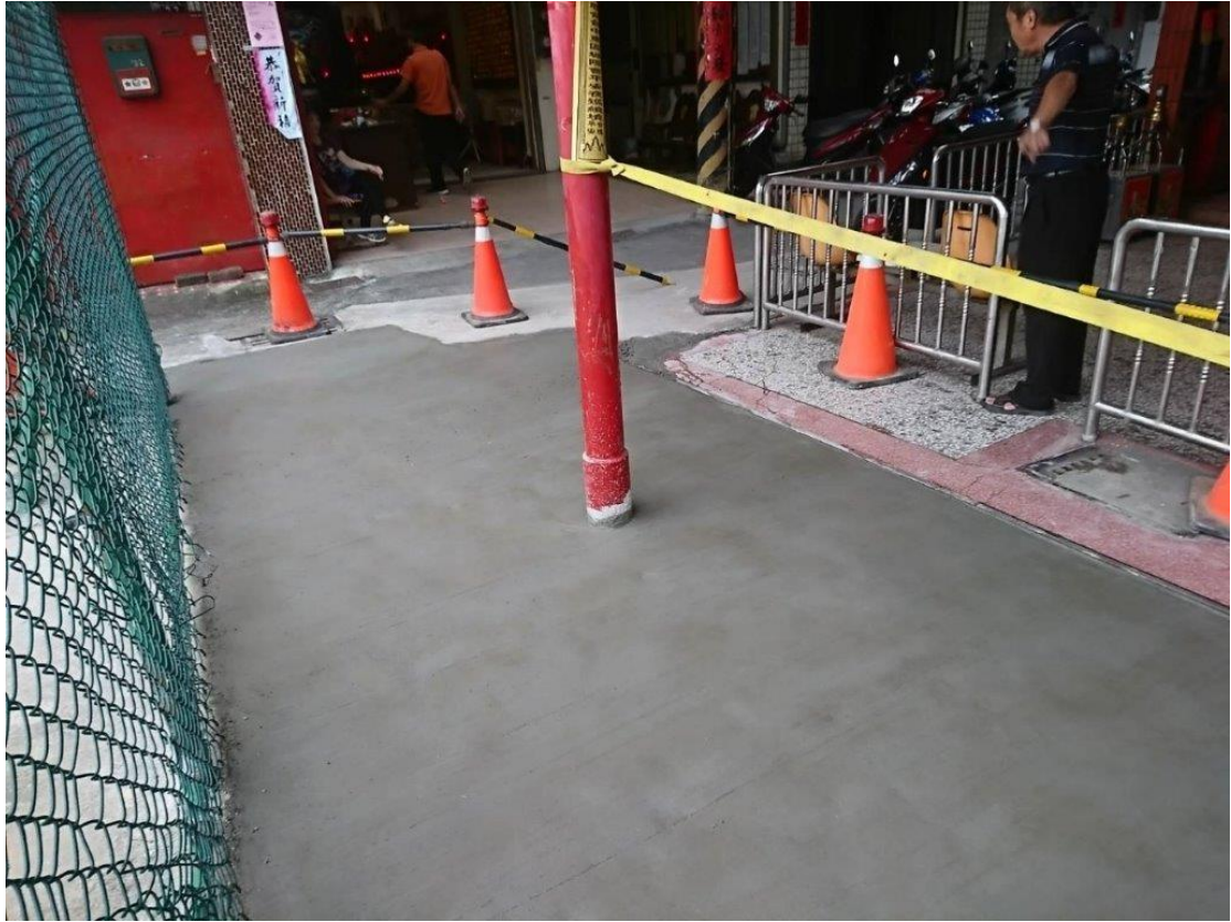
工區三 東區富仁里練武路 145 巷 8 號前路面改善工程 ( 上圖完工照片 )
