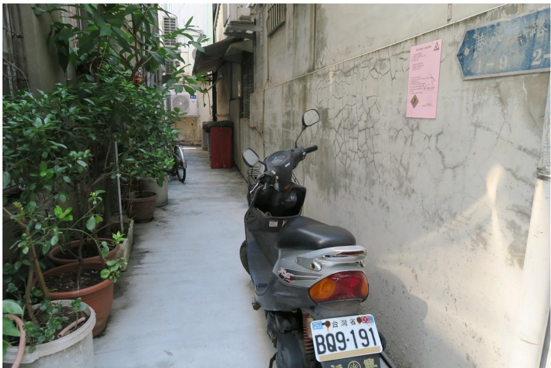
工區四 東區富仁里練武路 28 巷 ( 69 號對面 ) 路面改善工程 ( 上圖完工照片 )
