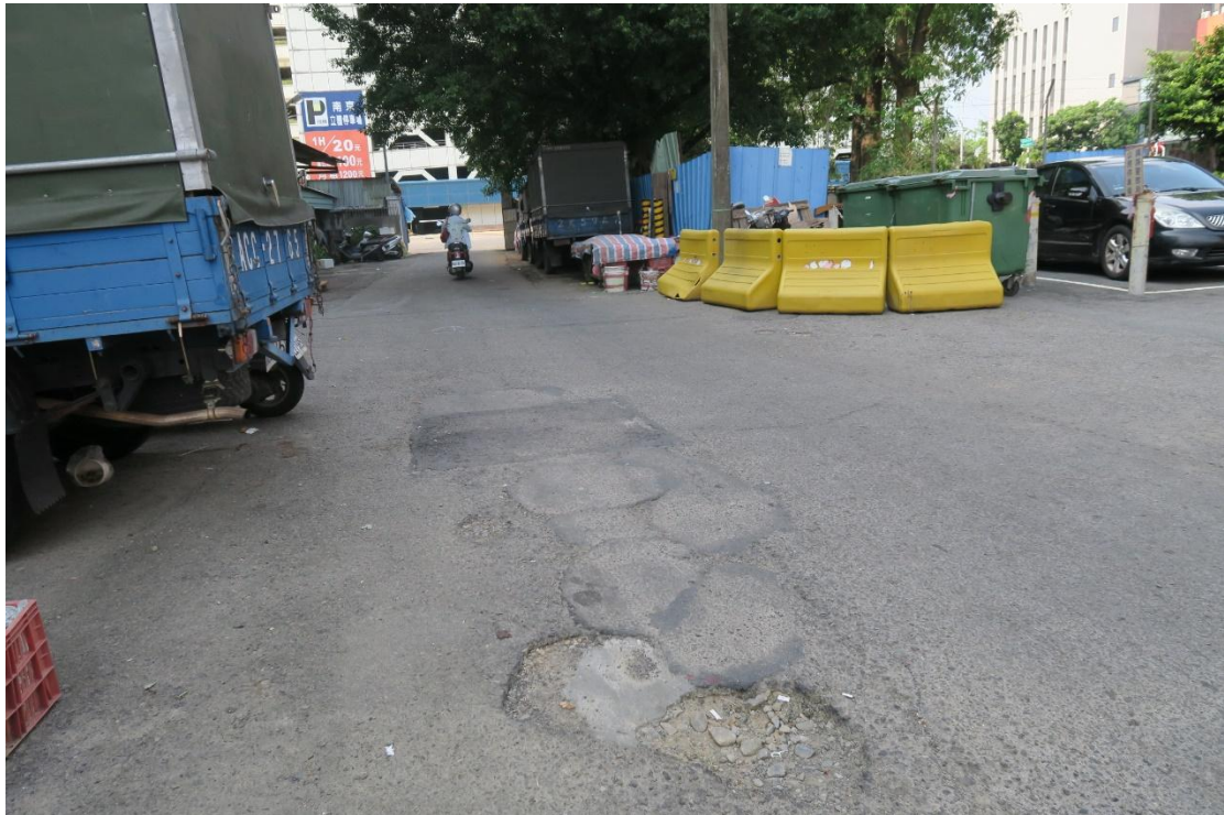
工區五 干城里南京路 117-7 號旁路面改善工程施工地點現況照片 108 年 8 月 即將施工改善路面
