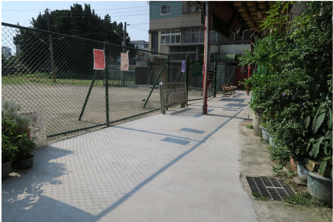
工區三 富仁里練武路 145 巷 8 號前路面改善工程 ( 上圖完工照片 )
