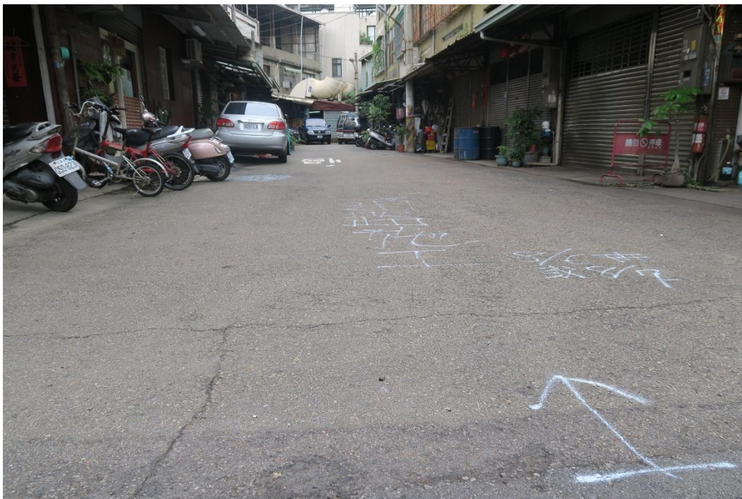
工區八 東門里東光園路 100 巷 52 弄路面改善工程施工地點現況照片 108 年 8 月即將施工改善路面 ( 上二圖：東光園路 100 巷 52 弄弄口至弄底 )
