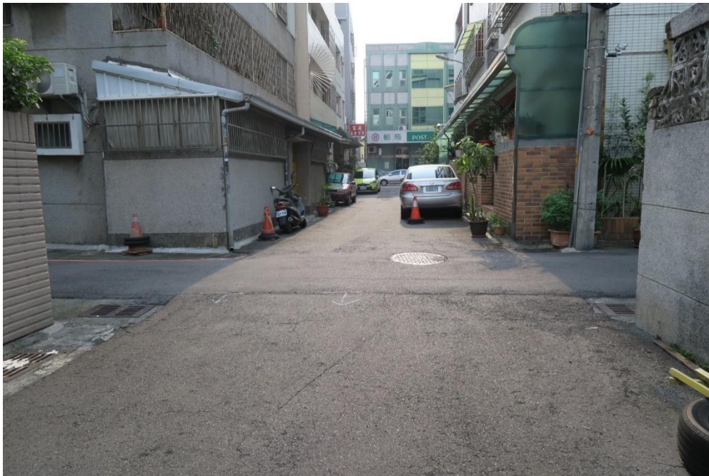
工區十一 合作里自強街 27 巷路面改善工程施工地點 108 年 8 月 6 日下午改善路面現場施工照片 ( 上二圖：施工中照片 下二圖：施工前照片 108 年 7 月 31 日拍攝 )
