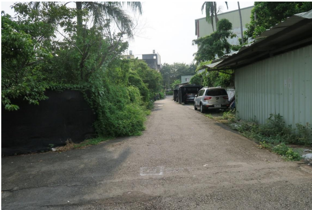
工區六 旱溪里東光路 76 巷 ( 東光路至旱溪五街 ) 路面改善工程施工地點 108 年 8 月 7 日下午路面改善現場施工完工照片 ( 上二圖 : 東光路巷口及旱溪五街巷口施工完工照片 中二圖 : 施工中照片 108 年 8 月 7 日拍攝 下二圖 : 施工前照片 108 年 7 月 30 日拍攝 )
