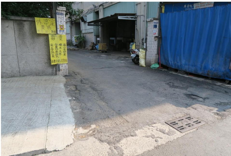
工區五 干城里南京路 117-7 號旁路面改善工程施工地點 108 年 8 月 7 日下午路面改善現場施工完工照片 ( 上二圖：施工完工照片 下二圖：施工前照片 108 年 7 月 30 日拍攝 )
