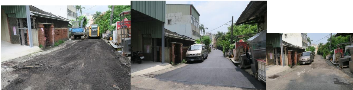
左三圖 工區六 旱溪里東光路 76 巷路面改善工程 施工中、施工後、施工前 照片
