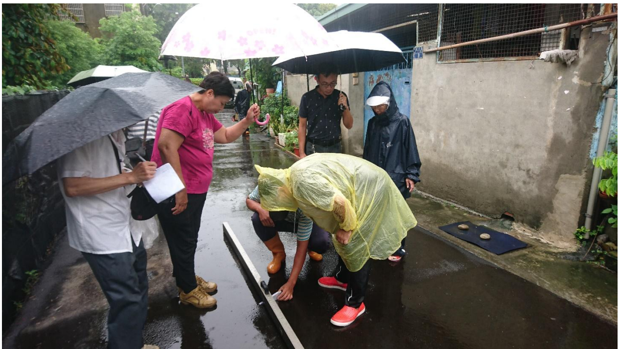
上四圖 抽查驗 工區六 旱溪里東光路 76 巷路面改善工程道路厚度及平整度
