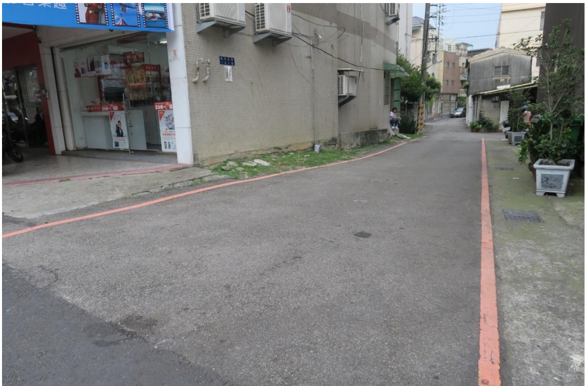
工區十 東英里精武東路 150 巷路面改善工程施工地點現場標線繪製完工照片 ( 上圖：標線繪製完工照片 中圖：完工照片 108 年 8 月 8 日拍攝 下圖：施工前照片 108 年 7 月 31 日拍攝 )
