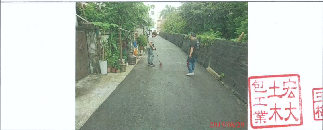
相片(3) 工區六 東區早溪里東光路76巷路面改善工程
