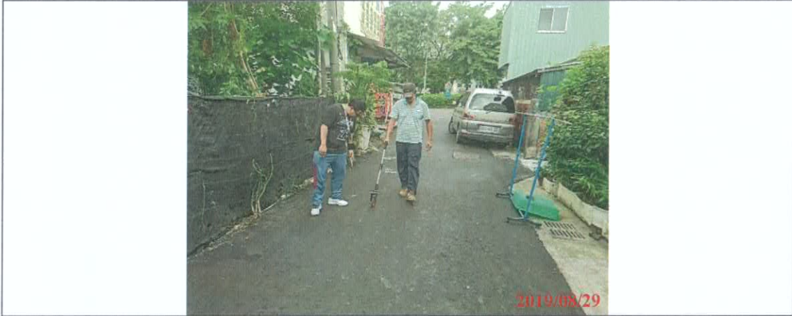
相片(4) 工區六 東區早溪里東光路76巷路面改善工程
