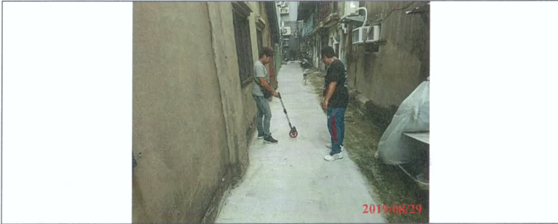
相片(1) 工區七 東區早溪里東光路76巷3弄路面改善工程
