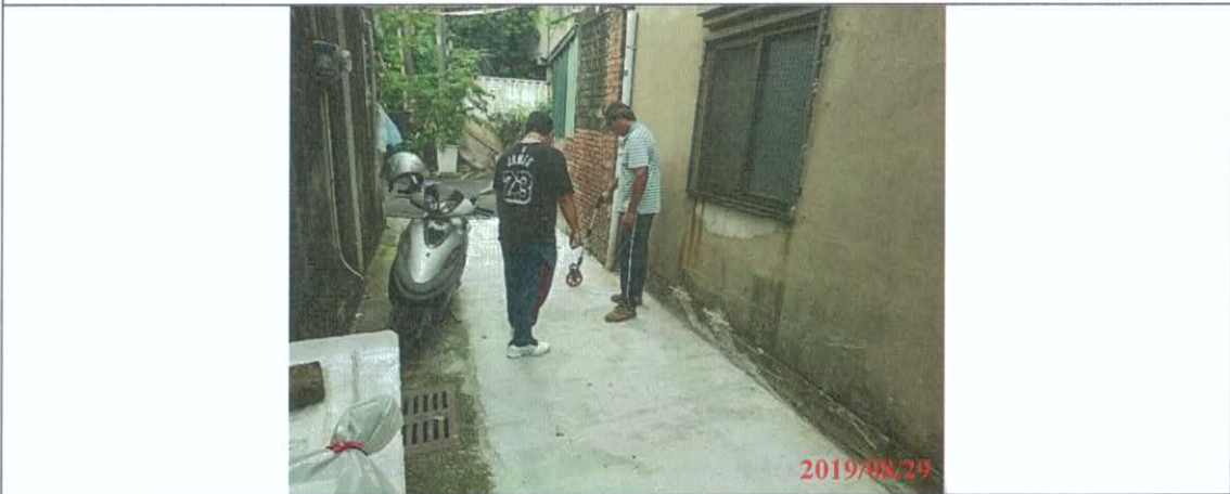
相片(2) 工區七 東區早溪里東光路76巷3弄路面改善工程
