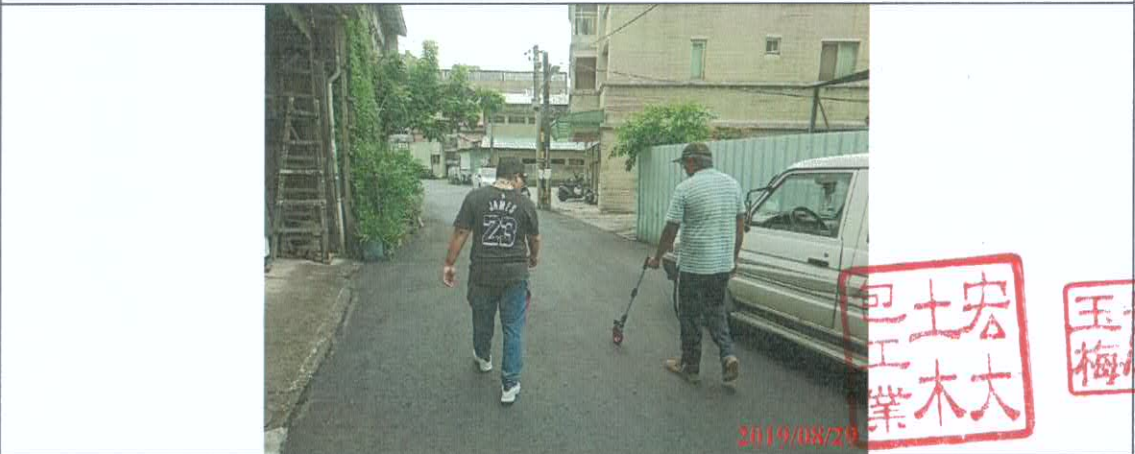
相片(6) 工區九 東區樂成里育英路23巷(東英二街~育英路)路面改善工程
