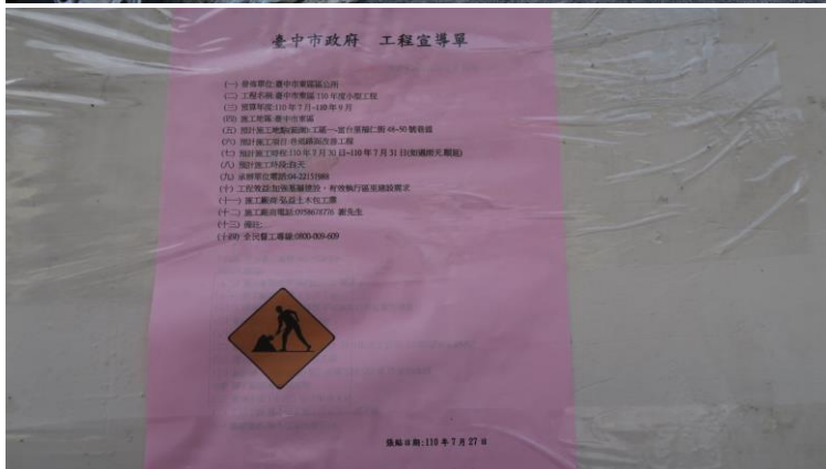
工區一 富台里福仁街 48~50 號巷道（福仁街至富台街）路面改善工程施工地點現況照片 110 年 7 月 30~31 日即將施工改善路面
