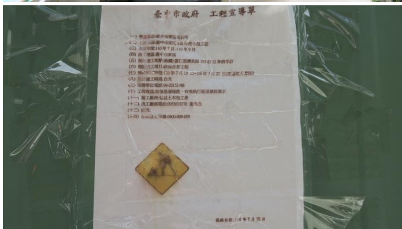
工區十 富仁里練武路 293 巷 12 弄前半段路面改善工程施工地點現況照片
