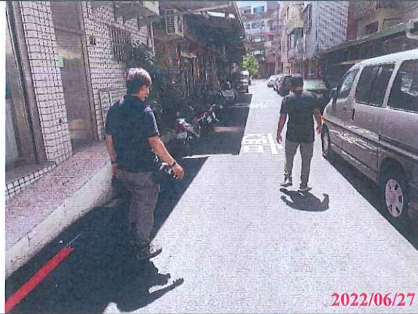
相片(4) 1-10工區-泉源街38巷道路改善工程
