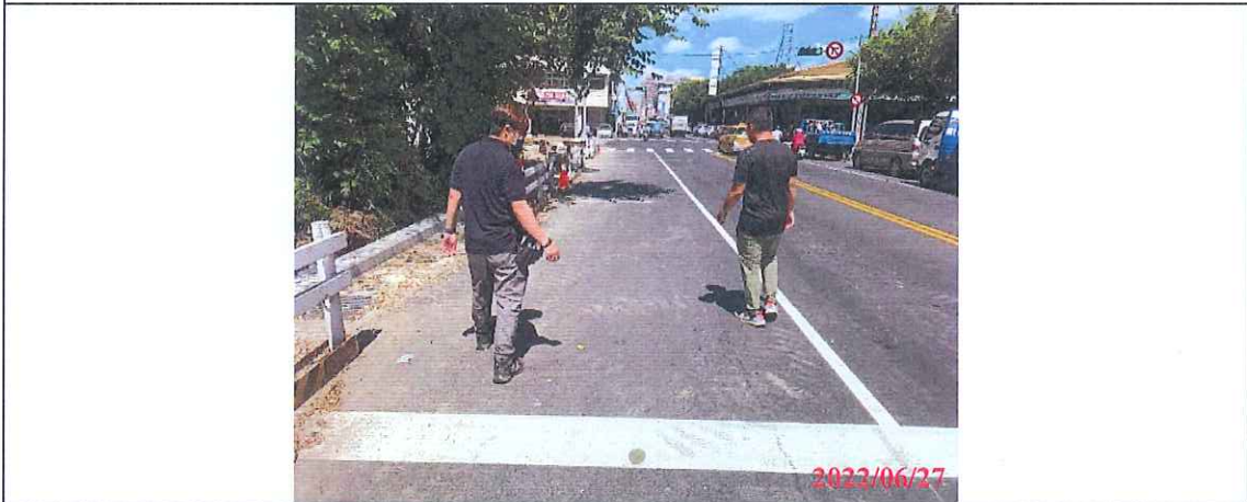
相片(2) 1-4工區-建德街(東光園路單號邊至建德街387號前段)道路改善工程
