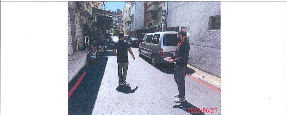
相片(3) 1-10工區-泉源街38巷道路改善工程
