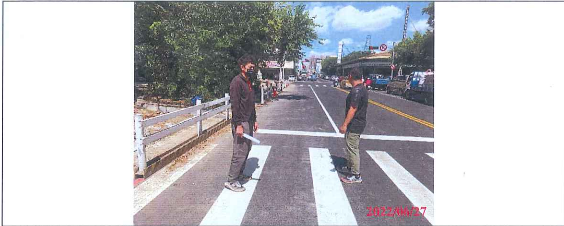
相片(1) 1-4工區-建德街(東光園路單號邊至建德街387號前段)道路改善工程
